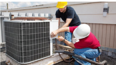
Услуги по монтажу инженерных систем
