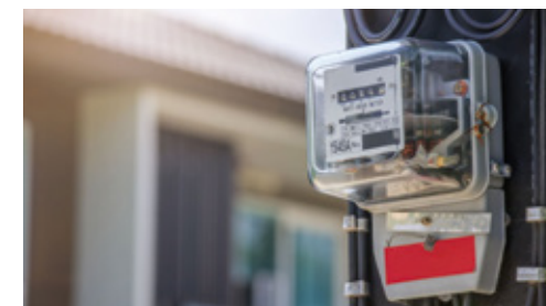
КИП и системы автоматизации
