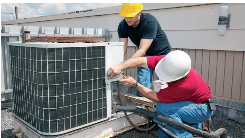
Услуги по монтажу инженерных систем
